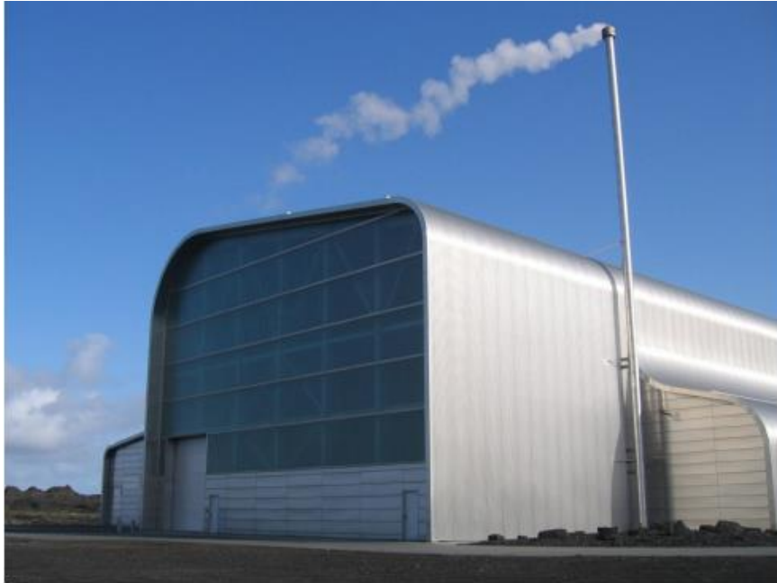
Mynd 3-4 Stöðvarhús Reykjanesvirkjunar.
