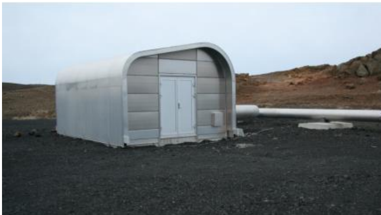
Mynd 3-2 Borholuhús við Reykjanesvirkjun.
