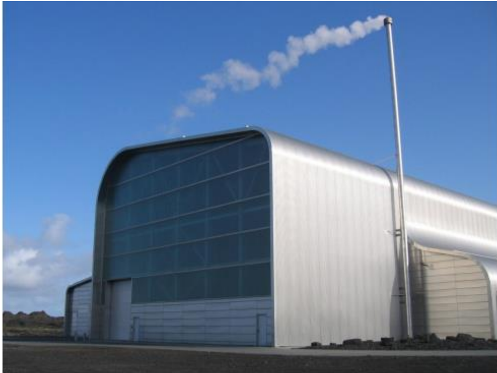
Mynd 3-4 Stöðvarhús Reykjanesvirkjunar.
