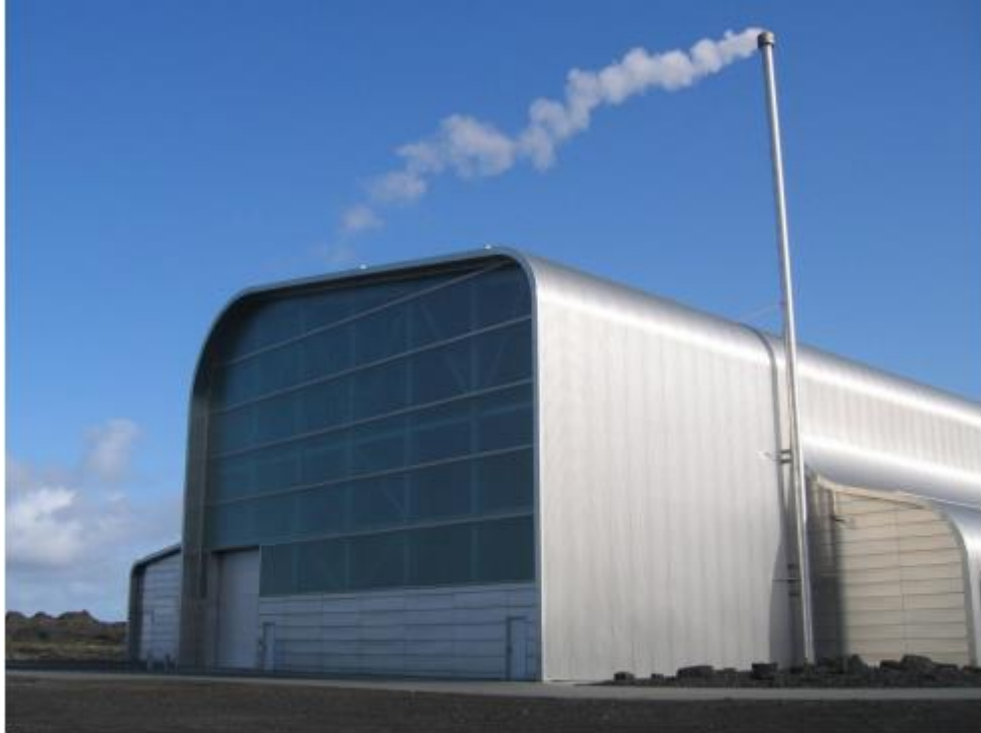
Mynd 3-3 Stöðvarhús Reykjanesvirkjunar.
