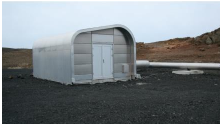
Mynd 3-2 Borholuhús við Reykjanesvirkjun.
