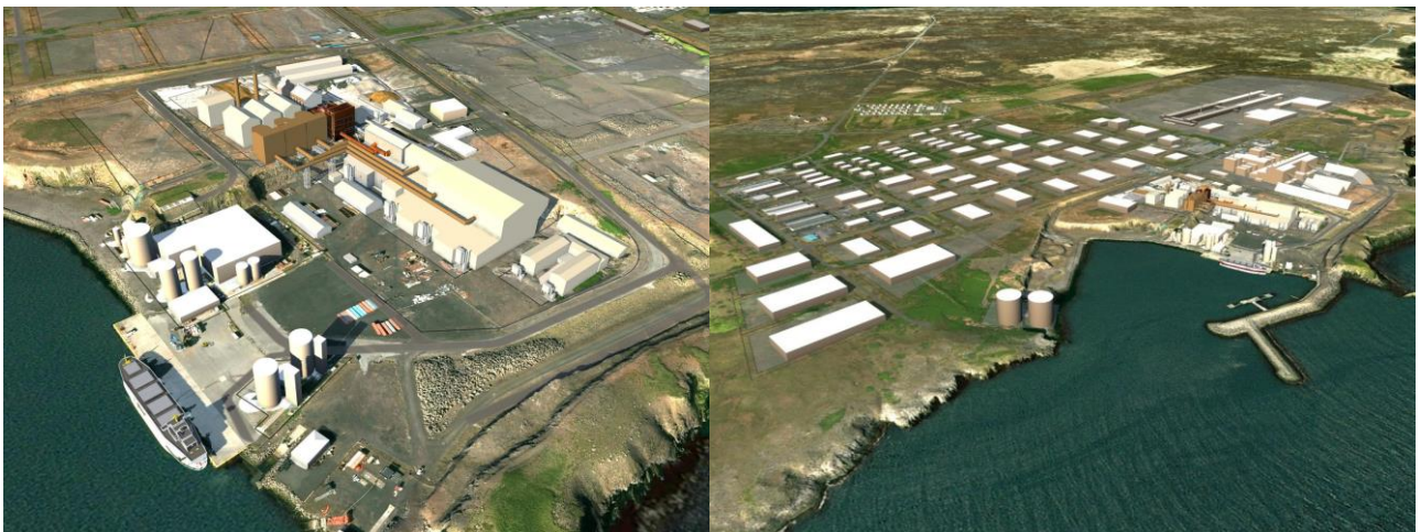
Mynd 8.48 Mannvirki fullbyggðar kísilverksmiðju Stakksbergs t.v. (með skematísku útliti framtíðarmannvirkja) og tilgáta um fullbyggt iðnaðarsvæði við Helguvík t.h.
