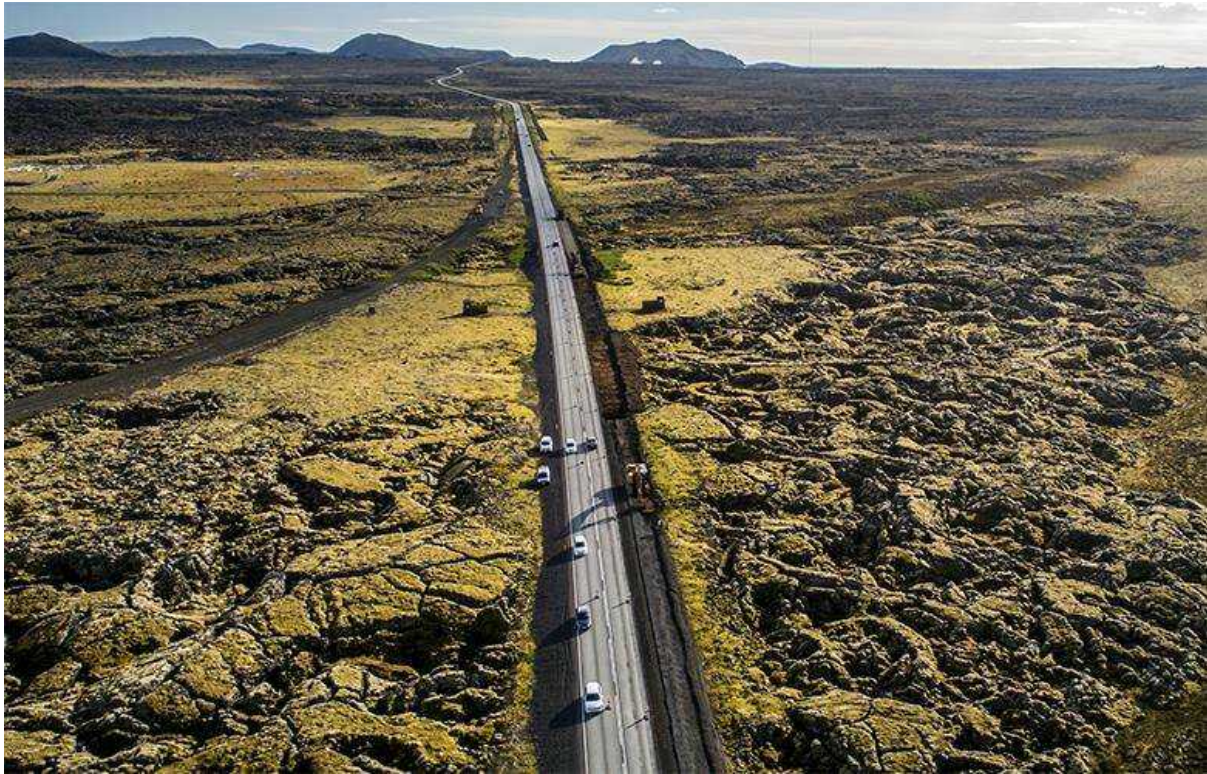
MYND 2.1 Yfirlitsmynd tekin yfir Grindavíkurveg. Sjá má að unnið er við hlið vegarins sumarið 2018.
